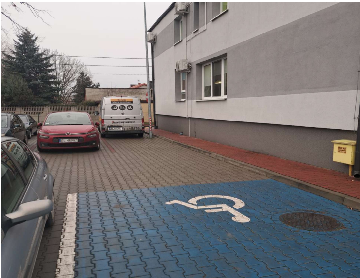
Budynek przychodni od strony ul. Parkingu wewnętrznego i miejsca planowanej dobudowy windy
