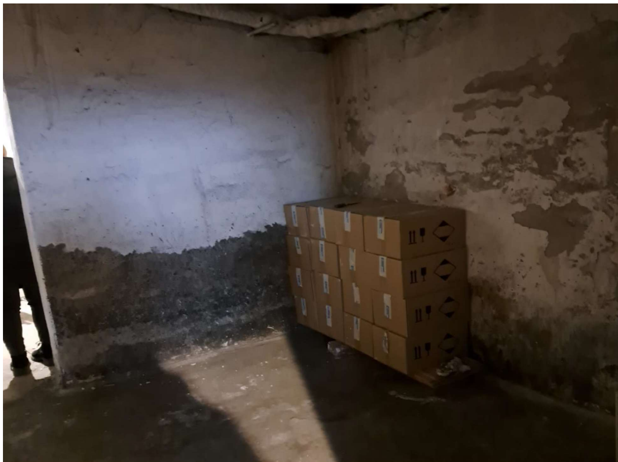
Widok na pomieszczenia piwnic do adaptacji
